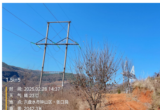
T 接入 110kV 高砂线 138#杆
