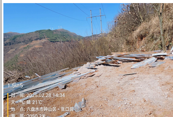
T 接入 110kV 高砂线 139#杆
